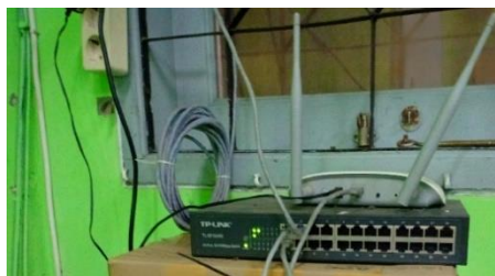
Gambar 1 Pengecekan Instalasi Jaringan
