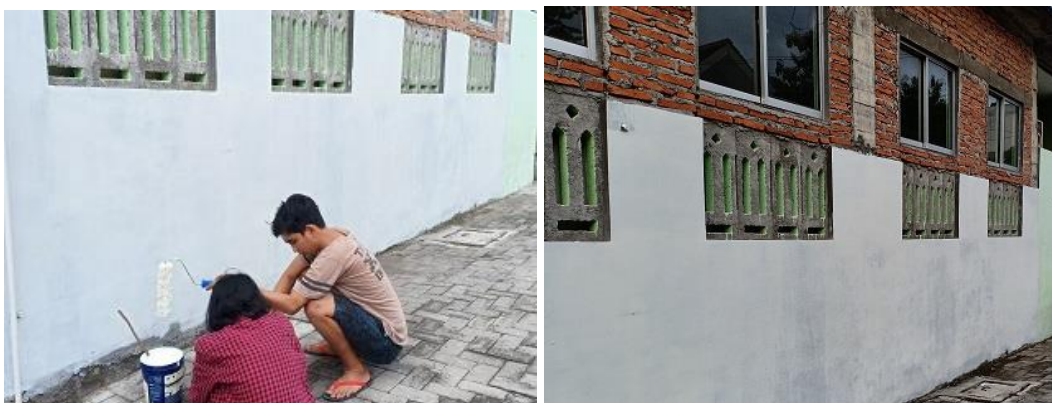
Gambar 3. Pengecatan dasar dinding
