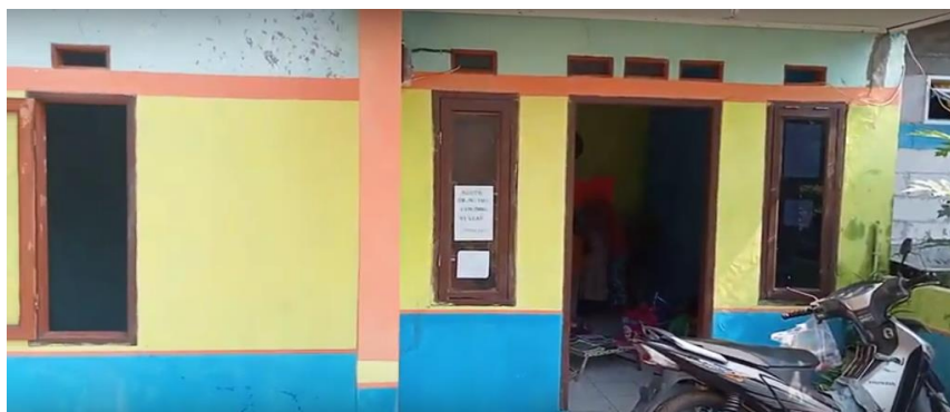
Gambar 1 Gedung RBM Tampak Depan
