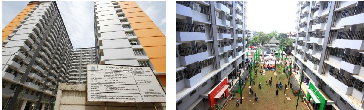
Gambar 7 dan 8. Kondisi rumah susun Angke, Tambora setelah dilakukan peremajaan Sumber: tempo.co
