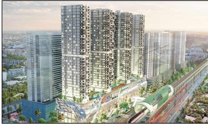
Gambar 2. Green Avenue di Stasiun LRT Bekasi
