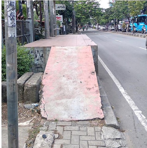
Gambar 12. Ramp pada sebuah halte bus di Jl. H. Juanda Sumber: Penulis, 2022.
