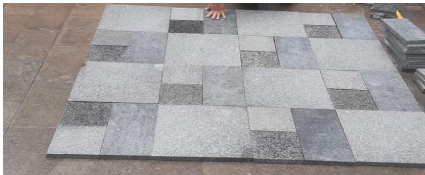
Gambar 18. Area Pemasangan Andesit
