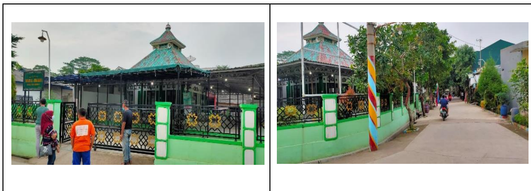
Gambar 1. Kondisi Eksisting Tapak
