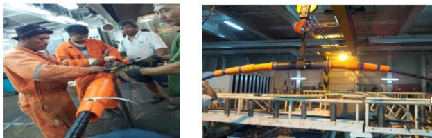
Gambar 19. Proses Penyambungan Kabel Fiber Optik
