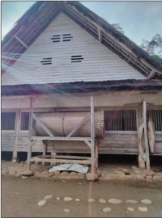
Gambar 2. Bedug dan Kentongan di Pelataran Masjid Kampung Naga Sumber: Dokumen Pribadi, 2023
