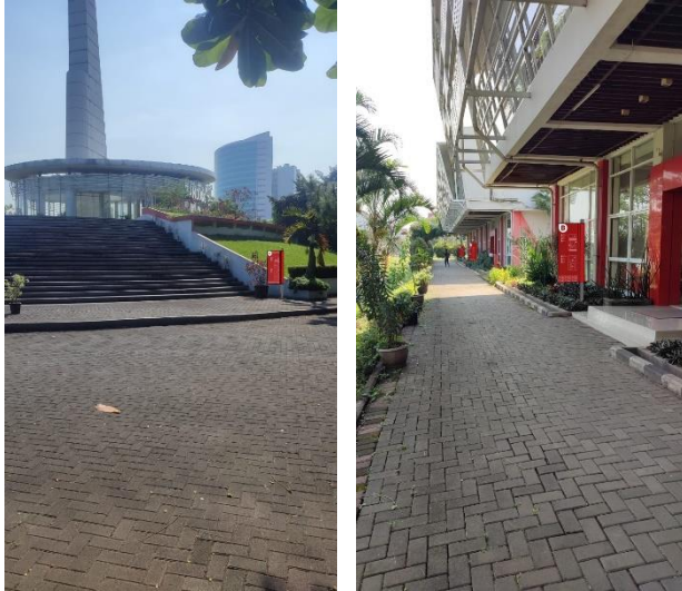
Gambar 10. Titik signage pada bangunan di kawasan BTP
