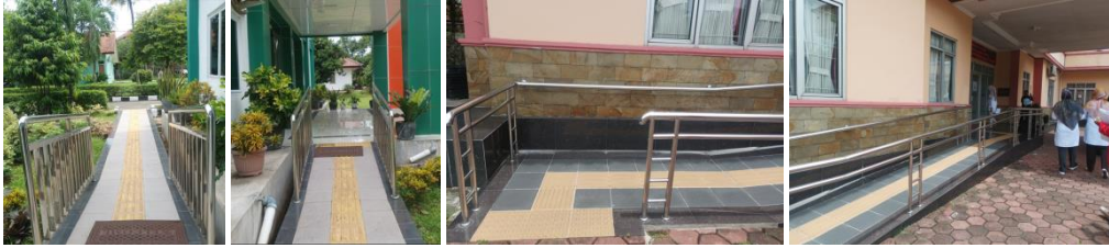
Gambar 5. Pintu masuk Gedung Sentra Handayani terdapat bidang miring atau ramp khusus pengguna kursi roda sudah sesuai standar dengan desain inklusif (Sumber: Permen PUPR No 14/M/PRT/2017)
