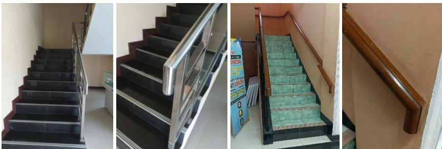
Gambar 9. Tangga kantor utama dan bangunan utama Sentra Handayani
