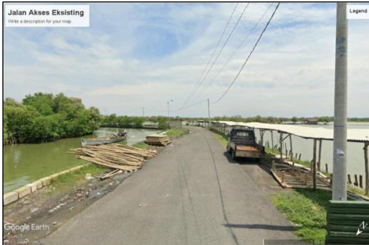
Gbr 5. Kondisi akses jalan di desa Kalanganyar, Sidoarjo.
