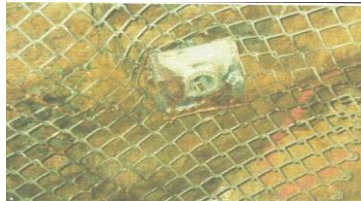
Gambar 4 Wire Mesh Dan Rock Bolt
