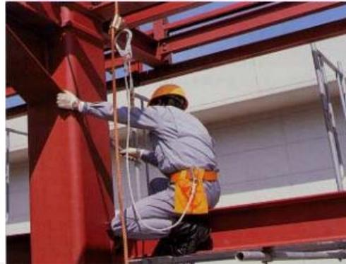
**Gambar 7. menggunakan safety belt dan helm pada saat bekerja di ketinggian**
