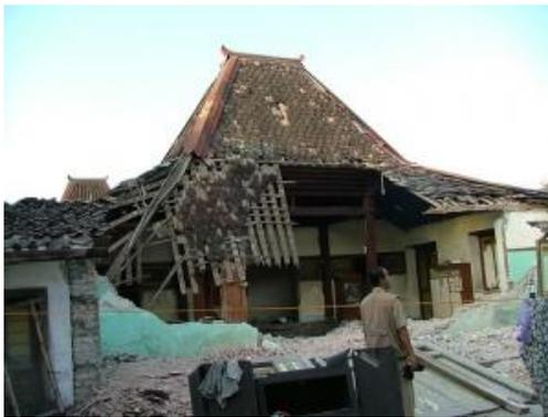
**Gambar 3. contoh konstruksi yang tidak memperhatikan standar bangunan tahan gempa**
