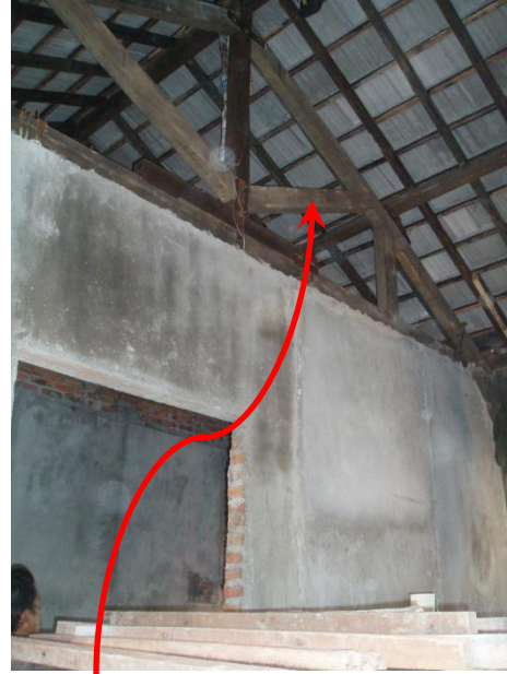
Pengecekan yang teliti, pastikan sampai rangka atapnya. Kuda-kuda lama masih cukup bagus dan kuat, jadi tidak perlu diganti dengan kuda-kuda baru.
