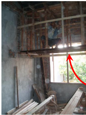
Steger yang menggunakan trik jitu, menghemat material.
