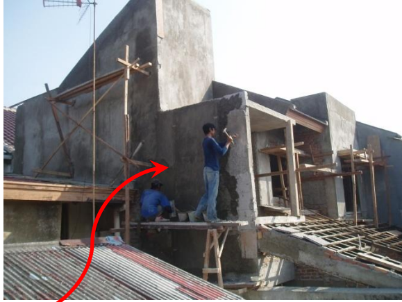
Cara memperbaiki dinding yang berbatasan dengan tetangga, tidak merusak kondisi rumah tetangga. Baloknya menggantung pada dinding.
